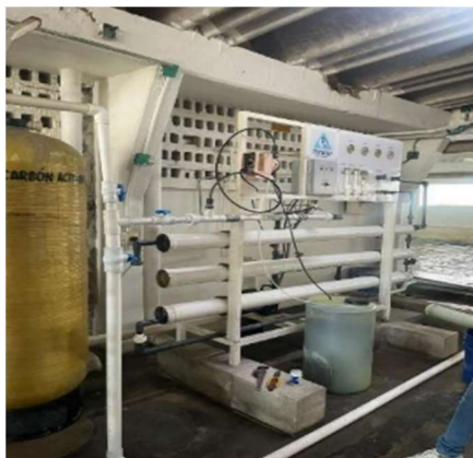
Figura 2.7. Filtro de ósmosis inversa (TSTECH)
