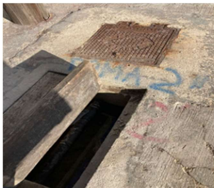
Figura 2.1 Cisterna de almacenamiento de agua potable
